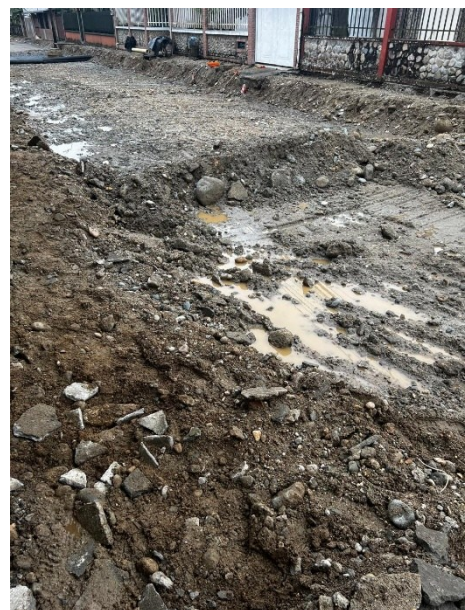
Rubro 6: DERROCAMIENTO DE BORDILLOS DE HORMIGON EXISTENTES (INC. DESALOJO)
