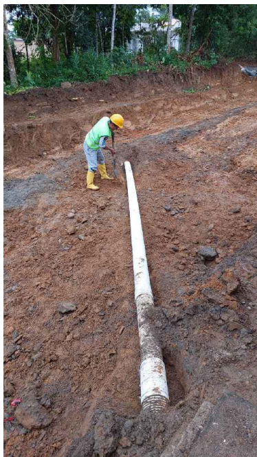
Rubro 73: REPARACION DE TUBERIA CORRUGADA Ø 200MM
